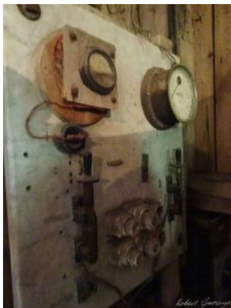
Ślad po elektrowni
