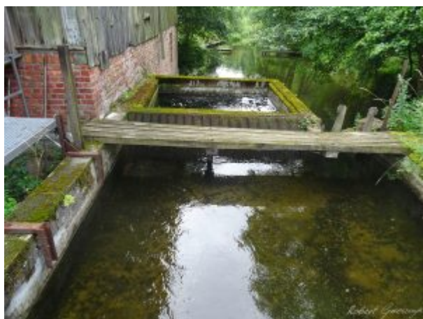
Kanał doprowadzający spiętrzoną wodę
